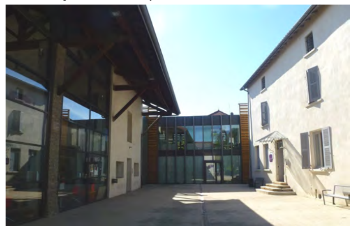
Réhabilitation - Feyzin © Troff J / Agence d'urbanisme de Lyon.
