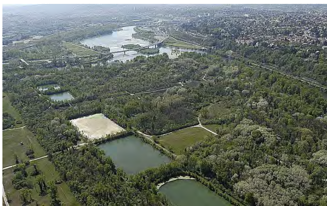
Zone de captage des eaux de Crépieux-Charmy
