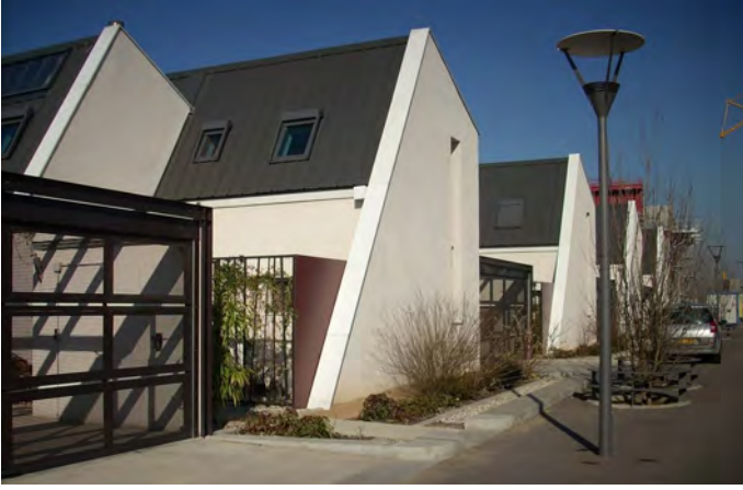
Logements de Haute Qualité Environnementale Hauts-de-Feuilly - Saint-Priest
