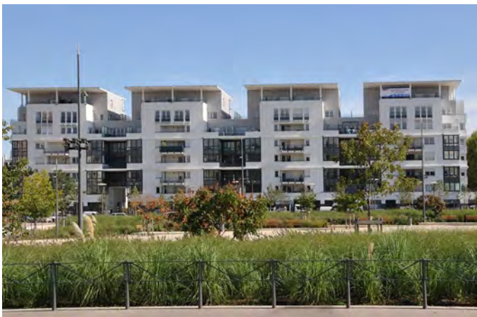
Logements collectifs - Lyon 7e
