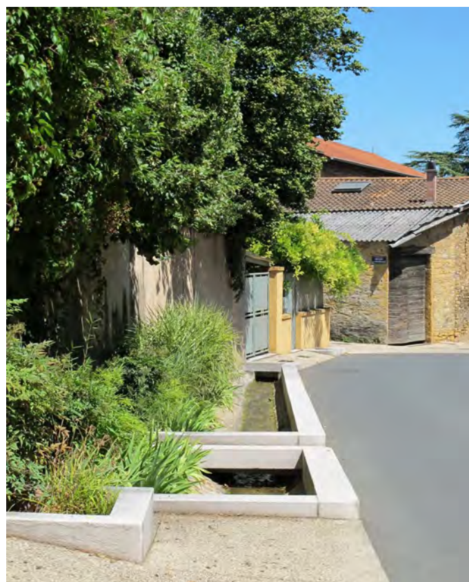
Aménagement paysager pour la gestion des eaux - Saint-Romain-au-Mont-d'Or © Agence d'urbanisme de Lyon.
