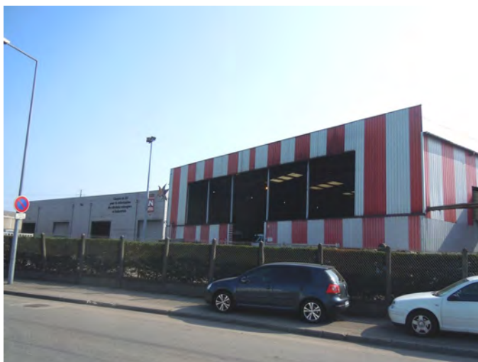
Centre de tri des déchets ménagers et industriels - Saint-Fons
