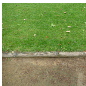
Bordure en grume de bois entre du béton et de l'herbe
