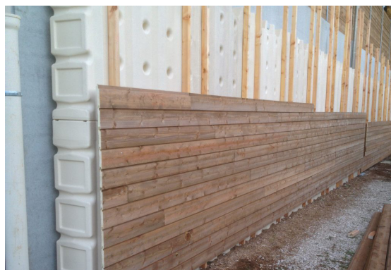
Exemple de stockage modulaire aérien, recouvert d'un bardage bois © Murdeau
