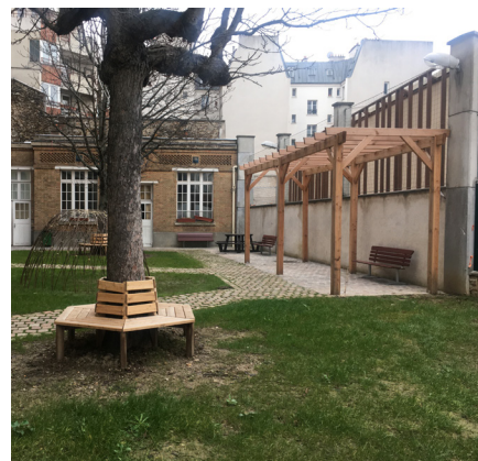
Pergola en bois avec ancrage au sol, école élémentaire Neuve Saint-Pierre, Paris © CAUE de Paris
