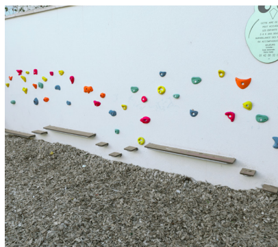
Réalisation d'un mur et support de jeu, en remplacement d'une grille provisoire, école Thionville, Paris © CAUE de Paris
