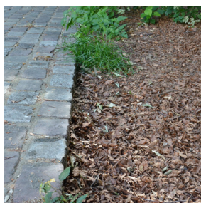
Décaissé entre un sol dur en pavés et des copeaux
