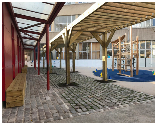
Pergola en bois avec ancrage au sol dans des fosses de pleine terre, école Emile Levasor, Paris © CAUE de Paris
