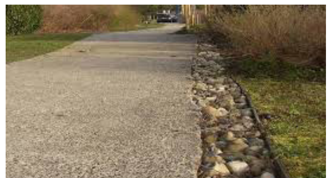
Tranchée drainante © Grand Lyon
