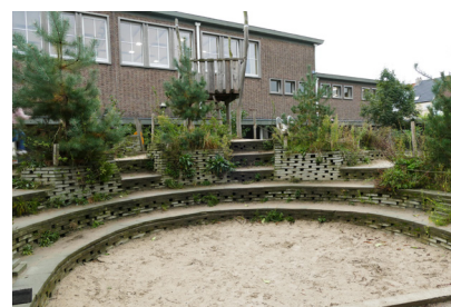
Gradins avec des dalles existantes, école De Piramide, Anvers © CAUE de Paris
