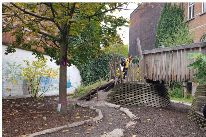
Butte en terre avec mur de soutènement en dalles réemployées, Anvers © CAUE de Paris
