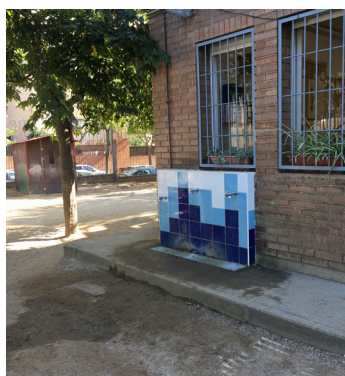
Robinetts extérieurs - école Mare Nostrum, Barcelone
