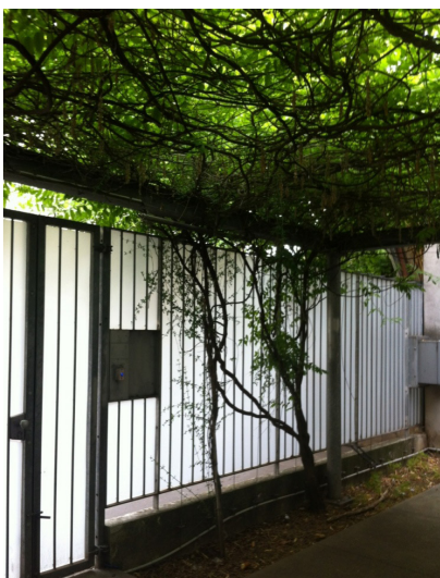
Pergola ajourée, structure porteuse acier (support de luminaires), avec fils guides inox, crèche des Maussins, Paris © CAUE de Paris
