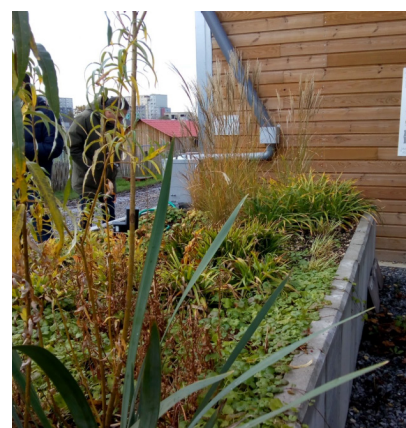
Jardin de Pluie à Saint-Denis hors sol, avec récupération de l'eau de pluie d'une toiture © Ville de Paris
