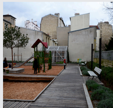
Aménagement de square, Paris © CAUE de Paris
