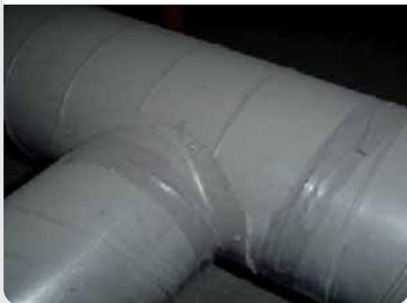
Photo 6 : Adhésifs détériorés sur conduits extérieurs
