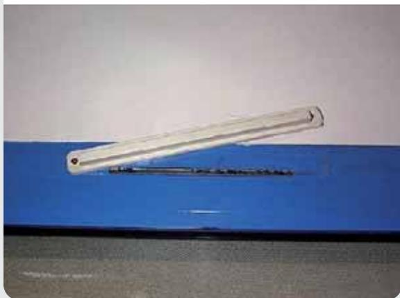
Photo 8 : Entrée d'air dans une fenêtre
