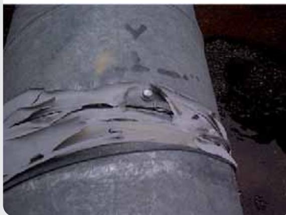
Photo 7 : Entrée d'air avec réservation trop étroite
