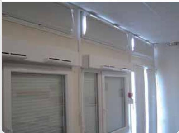
Photo 10 : Bouche de soufflage d'air dans une cantine
