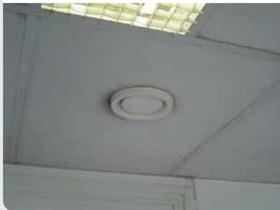
Photo 11 : Bouches d'extraction dans des sanitaires
