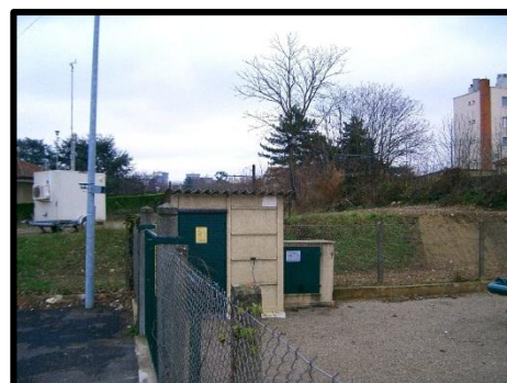
Photo du site « Valvert/Bd » à proximité d'un poste de gaz GDF
