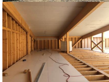
Fabrication du plancher
