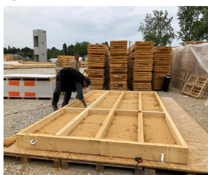
Préfabrication des caissons isolants pour la toiture
