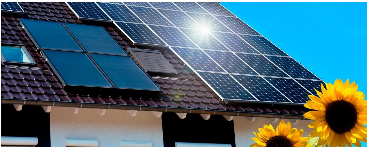
Le panneau solaire thermique produit de **la chaleur** : eau chaude sanitaire, de chauffage et/ou de process industriel.
