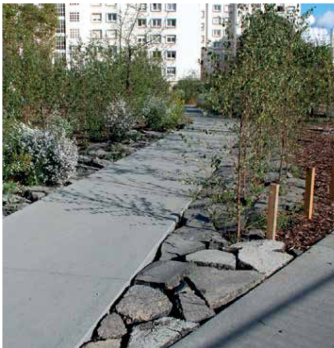
Conservation de dalles de béton pour les aires de jeux, réemploi de matériaux (enrobés) et maintien de la végétation en place
