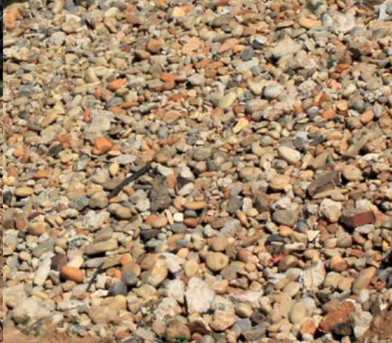
Stockage des gravats après tri des terres excavées
