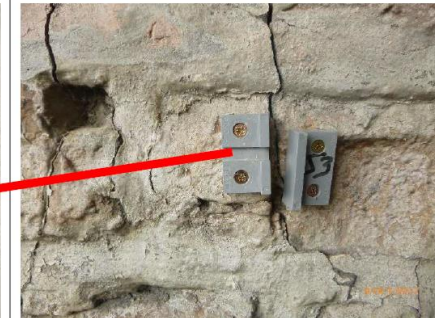
Jauge 3 – Fissure 3 – Vue depuis la montée Saint Sébastien
