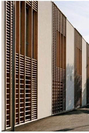
Protections solaires adaptées
