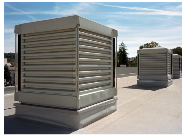
Tourelles de ventilation naturelle
