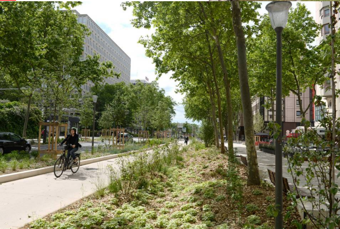
Rue Garibaldi réaménagée
